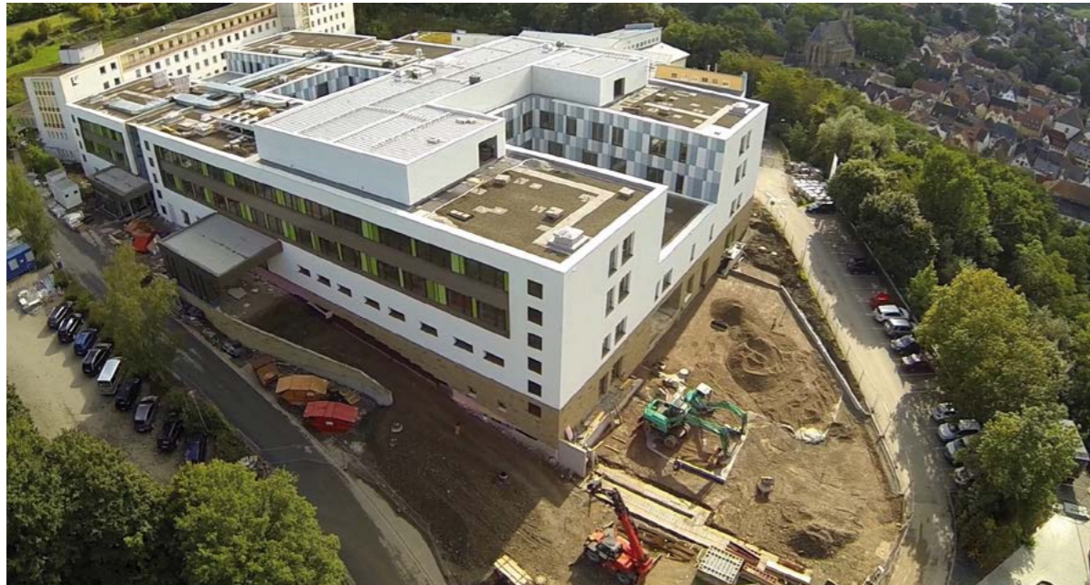
Blick auf den Neubau des Gesundheitszentrums, rechts die Altstadt von Meisenheim.
